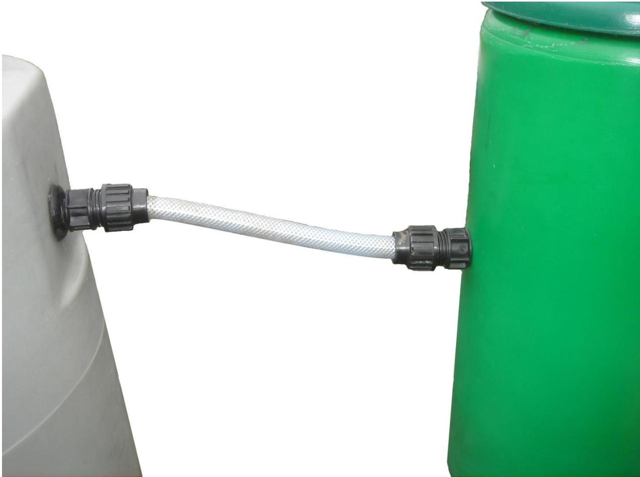
Visser l'autre raccord souple à la sortie du bac à chlore
